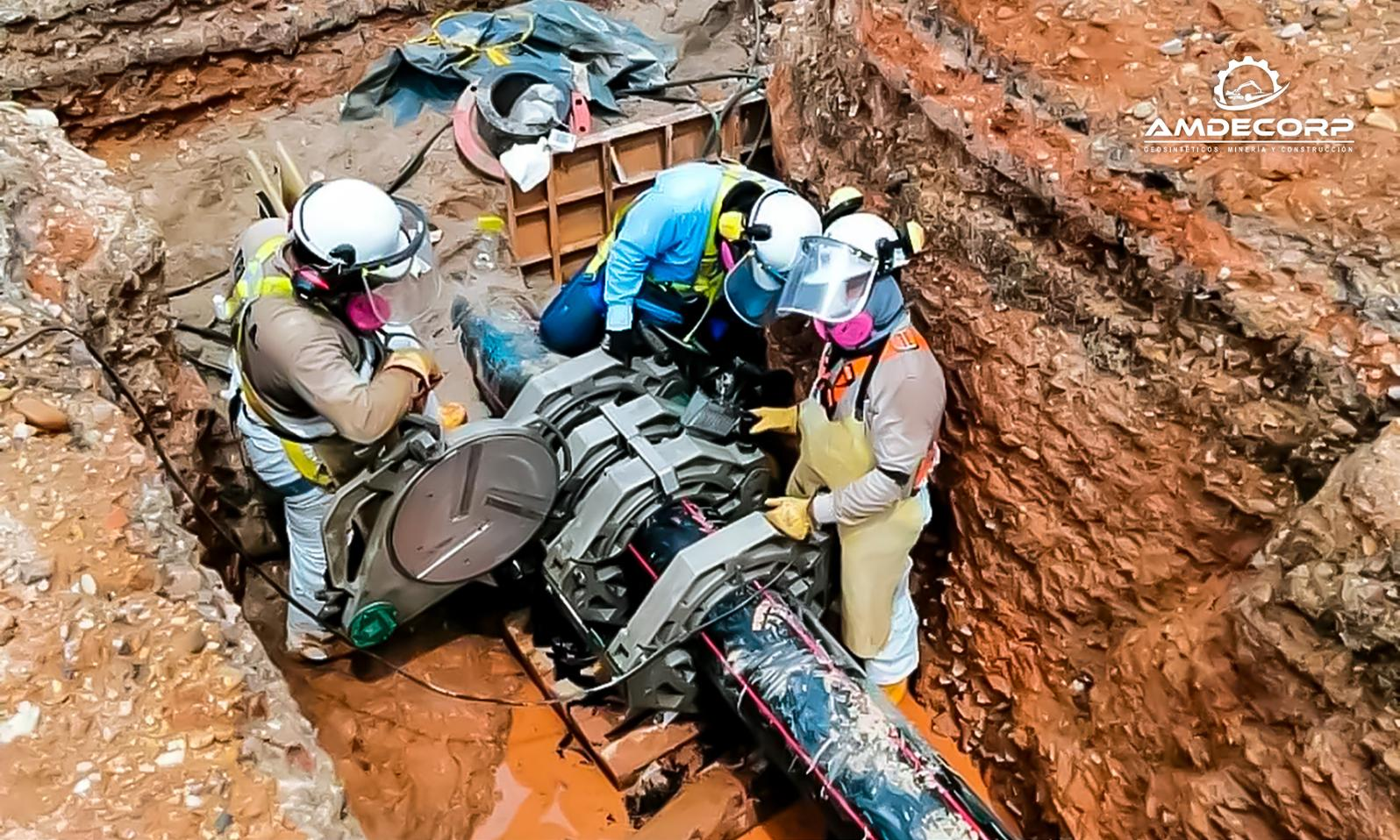
Es un método de soldadura simple y rápido, para unir tubos de polietileno y sus accesorios. Las áreas de las partes que se van a unir se calientan a la temperatura de fusión y se unen por aplicación de presión, con acción mecánica o hidráulica., de acuerdo al tamaño de la tubería y sin usar elementos adicionales de unión.
